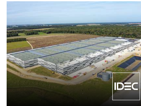
ABLIS (78) Construction de la plus grande plateforme logistique d'Europe de LIDL
