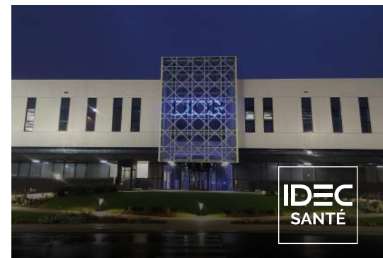
SAINT-JEAN-DE-BRAYE (45) Construction d'un laboratoire de contrôle qualité de 5 500 m 2 pour DIOR PARFUMS
